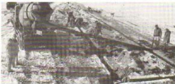
Dezember 1995: Baubeginn für die Tribüne auf dem erweiterten Sportgelände. Bei Schneegestöber und Temperaturen um den Gefrierpunkt machten sich Mitglieder ans Werk, um die Fundamentgräben auszuheben und den Betonsockel zu gießen.
