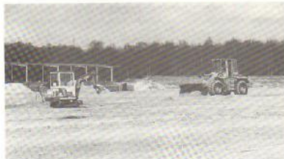
Nach mehrwöchigen Erdsarbeiten wurde der neue Rasen eingeseht.
